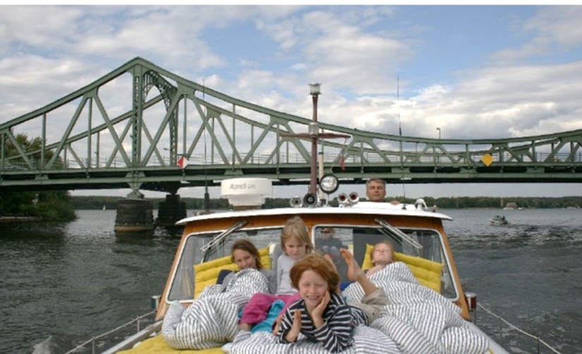
Bauwerk mit Symbolkraft: Die Glienicker Brücke über die Havel verbindet Berlin und Brandenburg
